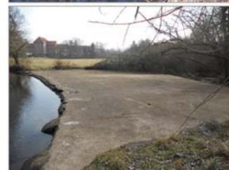
Fkm 2,8 - 3,0: Streichwehr mit Ausleitung zu einer Flutmulde (Hochwasserentlastung) Herstellung der Durchgängigkeit erforderlich. Möglicher Umbau zu einem "Umgehungsbach" über die Flutmulde.
