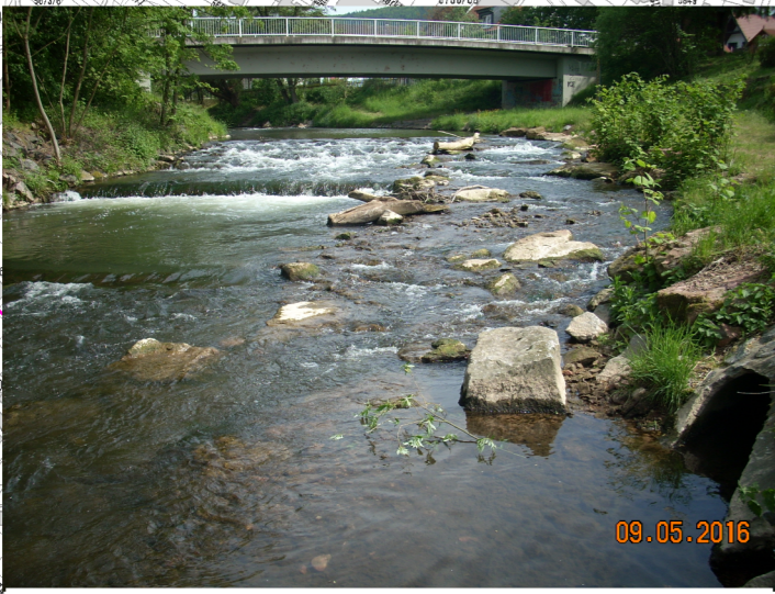
Sohlrampe in Burgstadt - mit "angehängter Rampe" 09.05.2016
