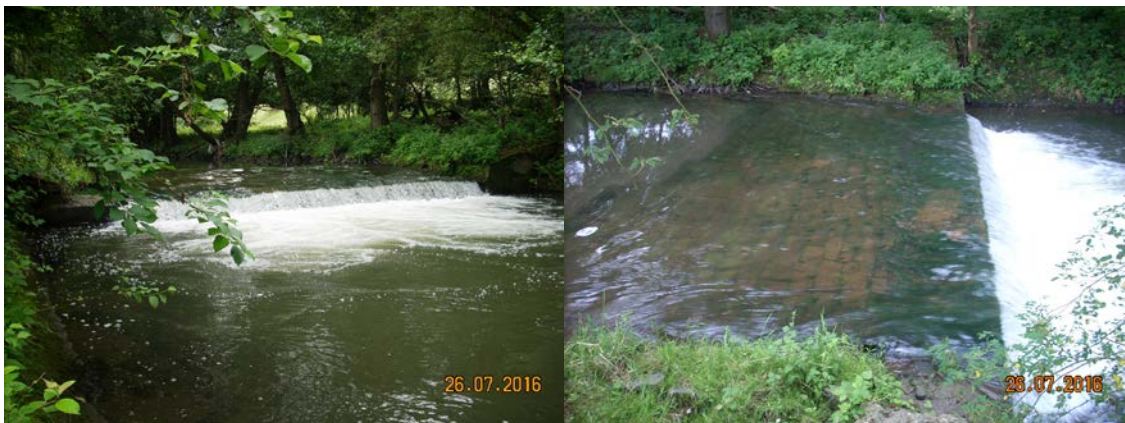
Ehemaliges „Kulturwehr“ mit gepflasterter Sohle Trapez-Riegel aus Beton
