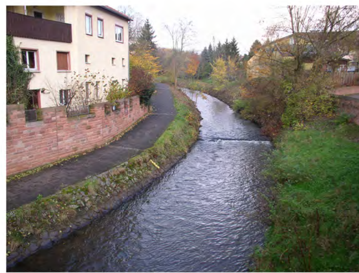
Zum Hochwasserschutz ausgebauter Bereich in Alzenau
