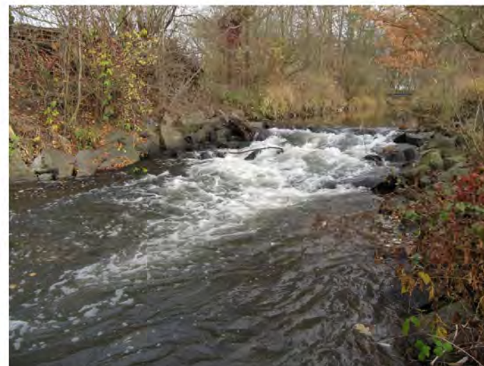
Sohlrampe bei Fkm 1.4
