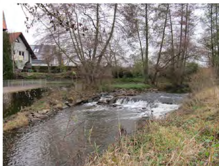
Teilweise bereits abgebrochene ehemalige Wehranlage "Sandmühle" (Becker) mit direkt angrenzender Ufermauer
