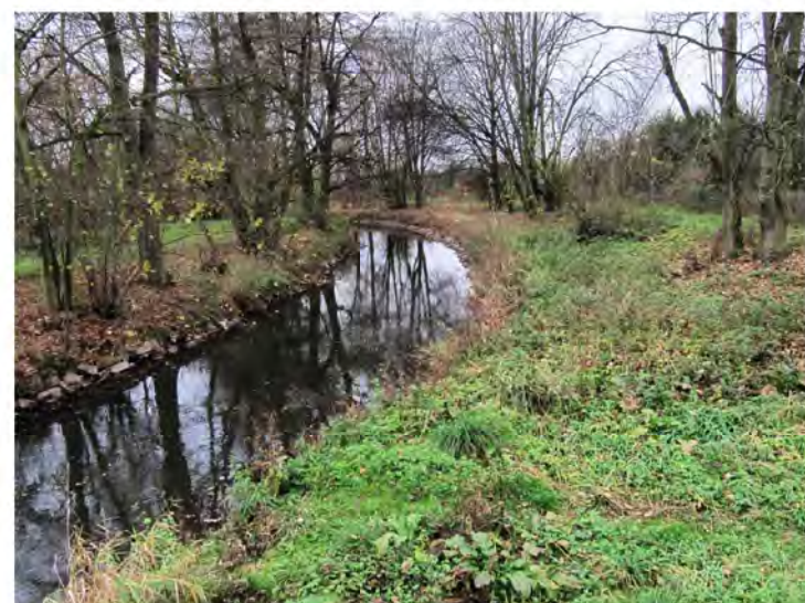
Stark versteinerte Kahl mit alten Schardeichen zwischen Fkm 1,9 und 2,4.
