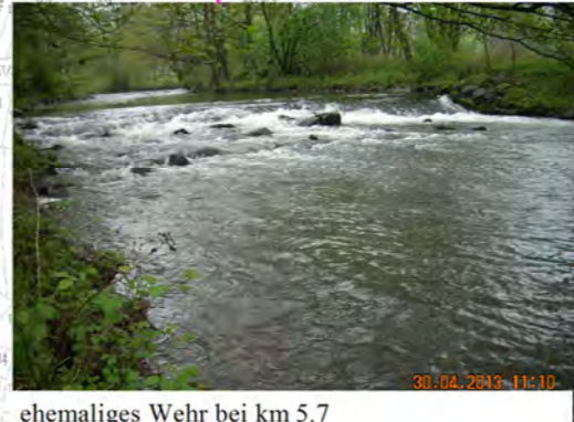
ehemaliges Wehr bei km 5.7
