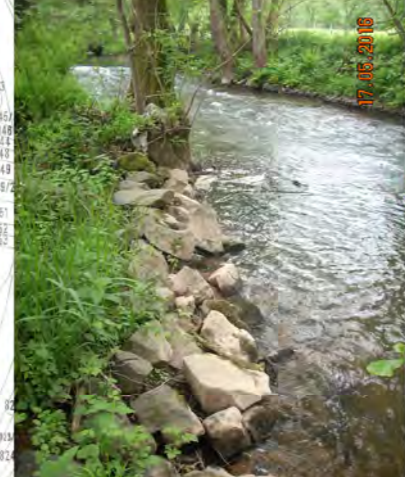
Steine der nicht notwendigen Ufersicherung entnehmen und bei Umbau der Schwellen verwenden
