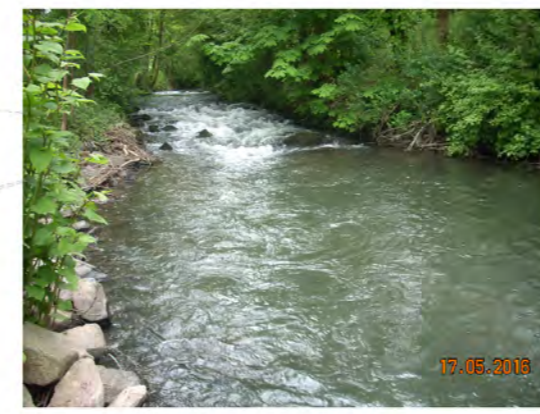
Rampe bei km 7.8
