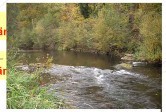
Beispiel für optimierte Grundschwelle bei km 4.4
