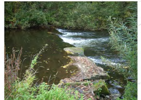
Zu eng gesetzte Steine - Steinriegel entzerren und Gegenschwelle einbauen
