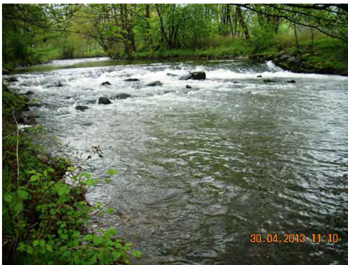
Umgebaute ehem. Wehranlage
