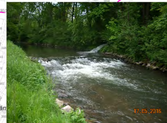
Grundschwelle an der Einmündung des Otterbaches
