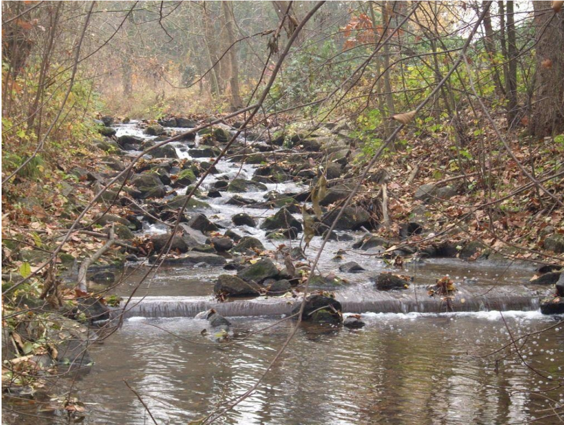
Sohlrampe bei km 0.8: „Mangelhaft“ durchgängig
